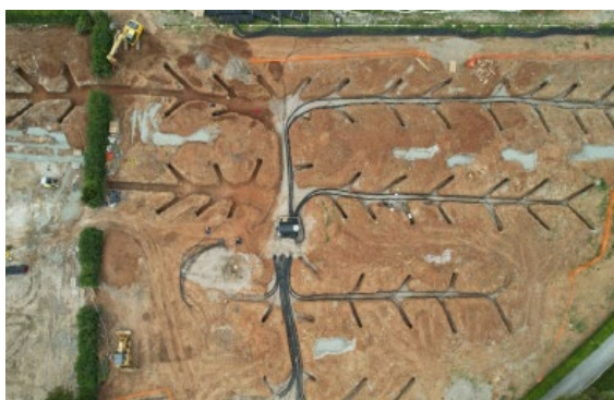
114 sonde verticali poste sino ad una profondità di 150 mt. - Potenza totale ricavabile dall'impianto pari a 855 kW.
