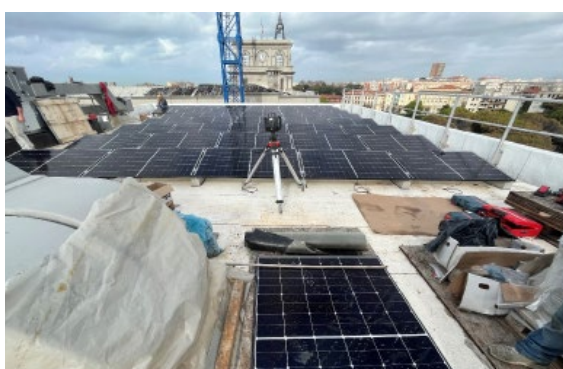
Particolare dell'impianto fotovoltaico (dimensione pannello 1768 mm x 1048 mm) - Potenza totale 38 kW.
