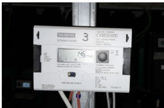
Pannello per monitoraggio produzione energia campo geotermico relativa alla pompa di calore acqua-acqua nr. 3
